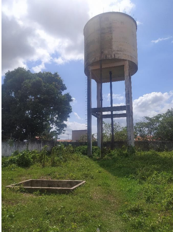
Figura 32 - Detalhe do Reservatório REL 01. Fonte: Própria (2021)
