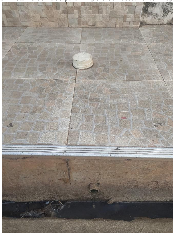
Figura 46 - Detalhe do Tubo para Limpeza da Fossa. Fonte: Própria (2021)
