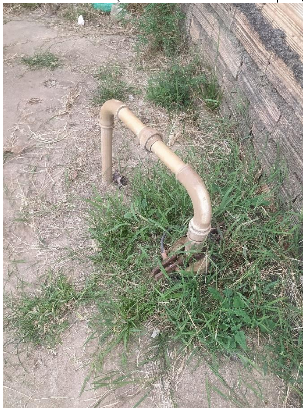
Figura 21 - Detalhe do Poço Bairro São João. Fonte: Própria (2021)
