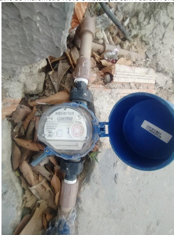
Figura 43 - Detalhe de Hidrômetro Velho, Instalação sem Padrão e Ligação sem Hidrômetro. Fonte: Própria (2021)
