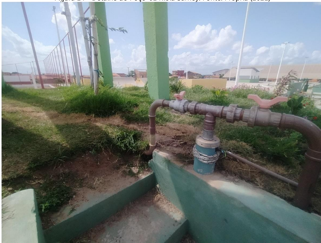
Figura 14 - Detalhe do Poço-01 Kiola Sarney. Fonte: Própria (2021)
