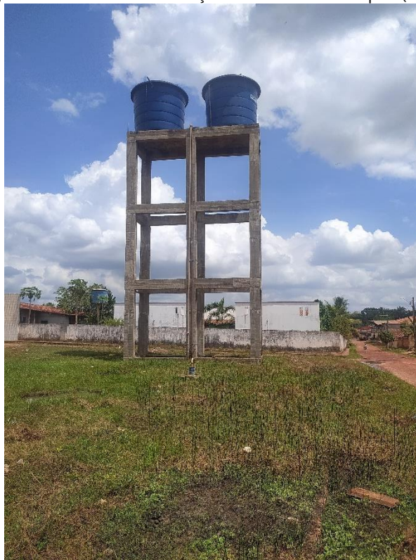
Figura 29 - Visão Geral do Poço 02 Pacas. Fonte: Própria (2021)
