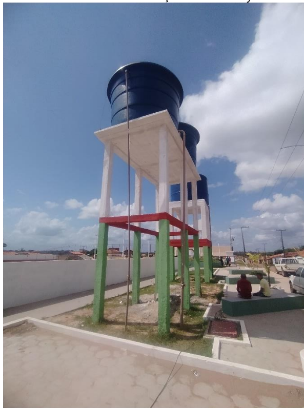
Figura 33 - Detalhe do Centro de Reservação Kiola Sarney. Fonte: Própria (2021)
