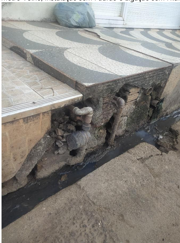
Figura 43 - Detalhe de Hidrômetro Velho, Instalação sem Padrão e Ligação sem Hidrômetro. Fonte: Própria (2021)
