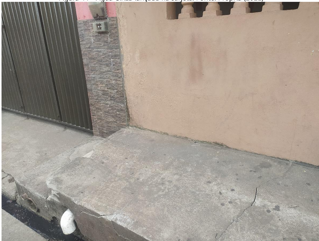
Figura 44 - Água Cinza lançada na sarjeta. Fonte: Própria (2021)
