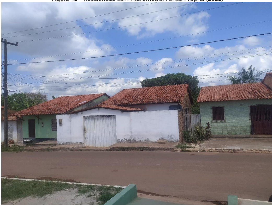
Figura 41 - Residências sem Hidrômetro. Fonte: Própria (2021)
