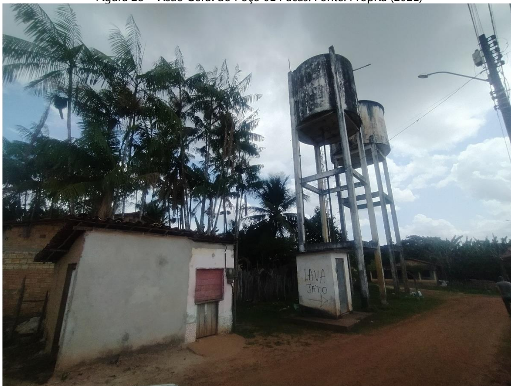
Figura 28 - Visão Geral do Poço 01 Pacas. Fonte: Própria (2021)
