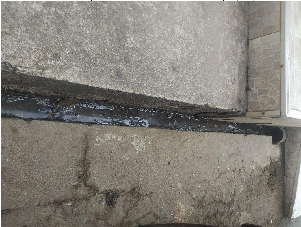
Figura 46 - Detalhe do Tubo para Limpeza da Fossa. Fonte: Própria (2021)
